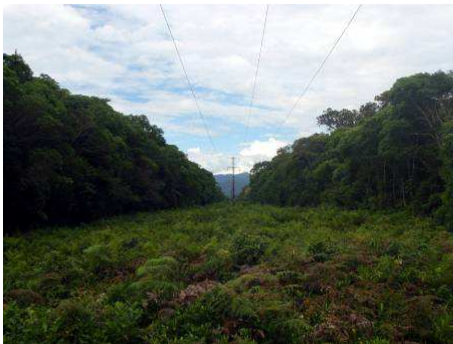
Foto 09 – Abertura de faixa em floresta de restinga alta para passagem de linha de alta tensão no município de Iguape.
